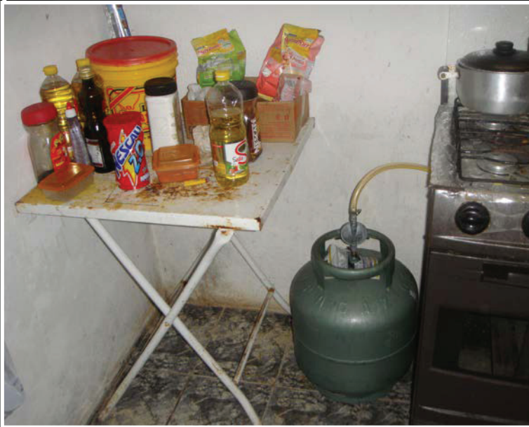
Botijão de gás em local inadequado ensejando risco de explosão e incêndio no local de trabalho.
